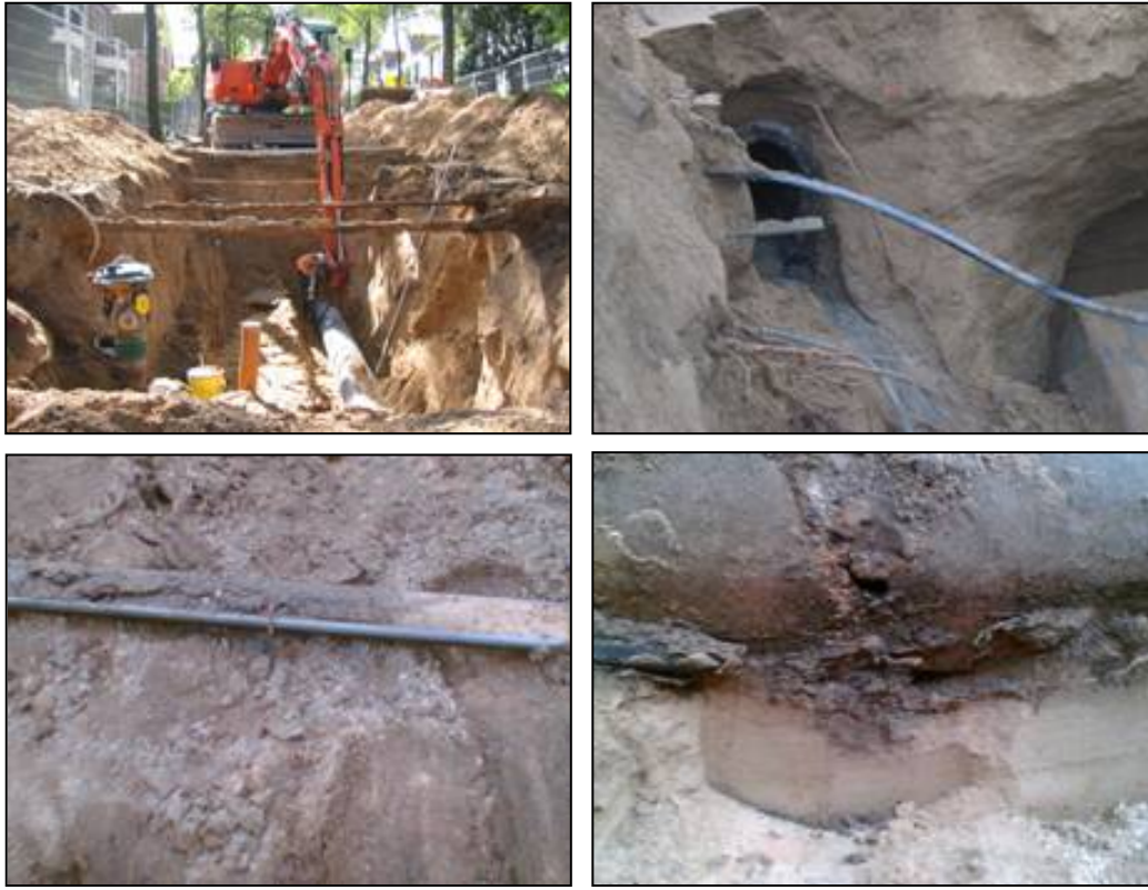
Figuur 5.1 Bemonstering grond onder lekkende riolering (Hilversum).
