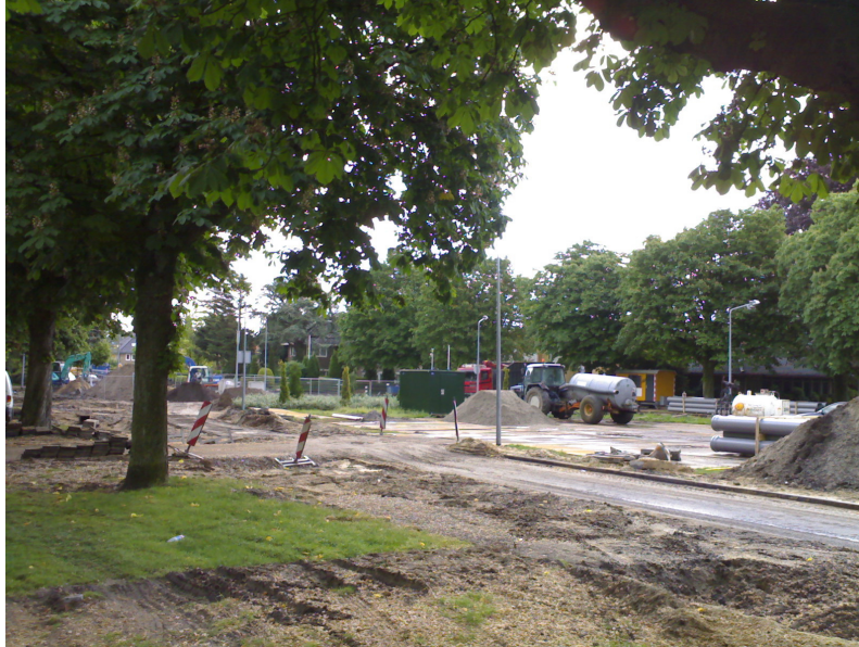
Afbeelding 5 Wegwerkzaamheden aan de Johannes Geradtsweg (dd 19 mei 2008)
